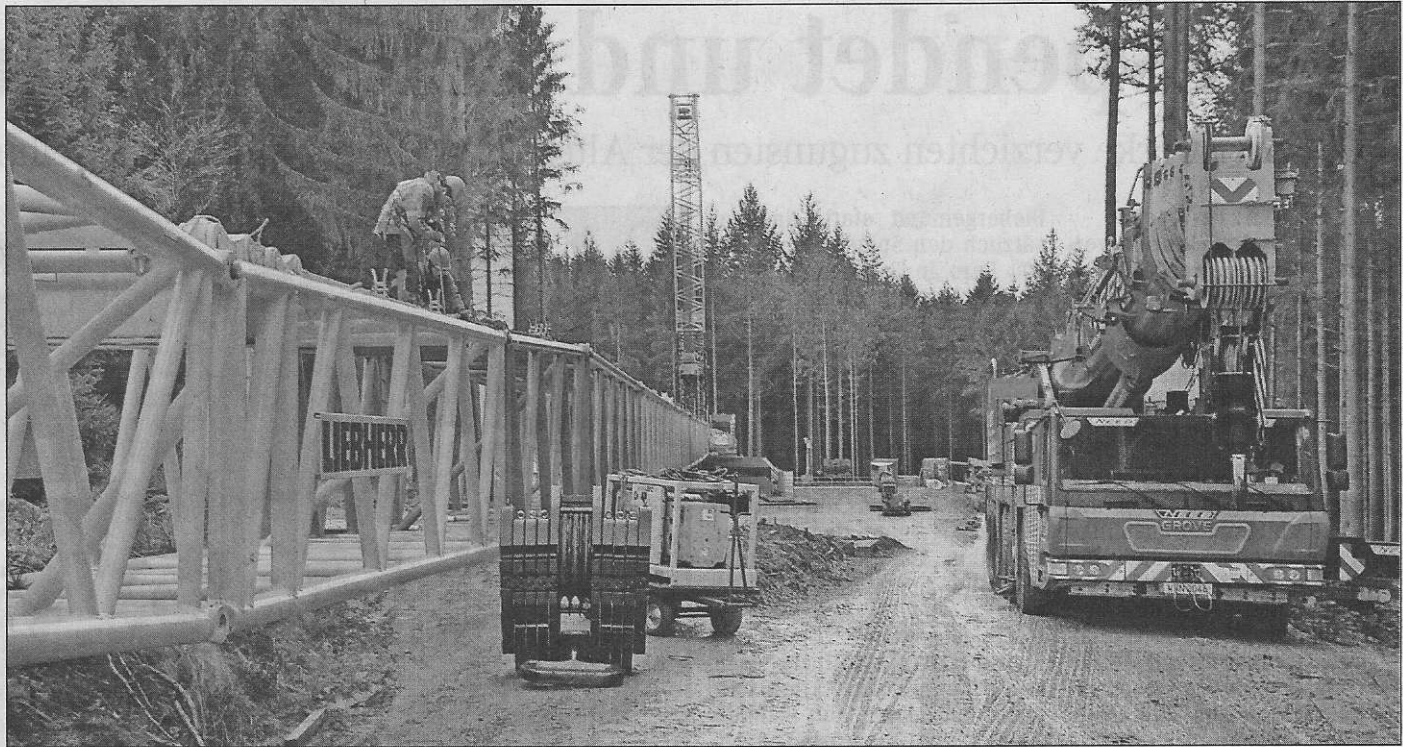
Mehr als 2 000 Lastwagen sind bereits über die Zuwege zur Großbaustelle gerollt, davon zahlreiche Schwerlasttransporter.
